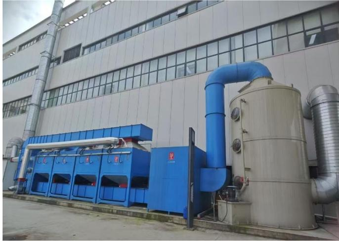
“碱喷塔+一级干燥过滤+活性炭吸附+CO催化燃烧”处理设施（TA001）+30m高排气筒（DA001）
