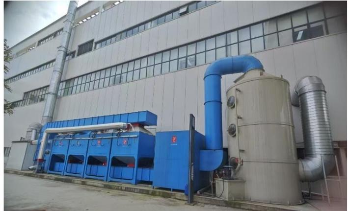
“碱喷塔+一级干燥过滤+活性炭吸附+CO催化燃烧”处理设施 (TA001)+30m高排气筒 (DA001)
