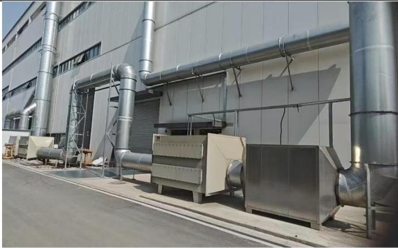
“油烟净化器+一级干燥过滤+二级活性炭”处理设施（TA004）+30m高排气筒（DA002）
