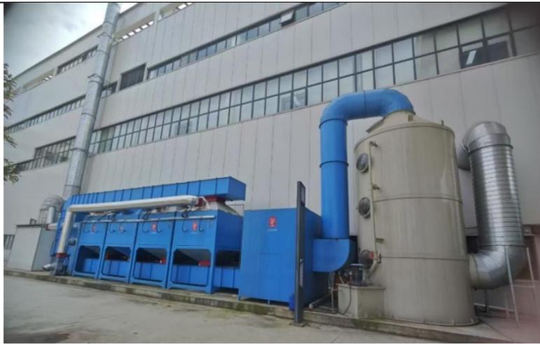
“碱喷塔+一级干燥过滤+活性炭吸附+CO催化燃烧”处理设施（TA001）+30m高排气筒（DA001）
