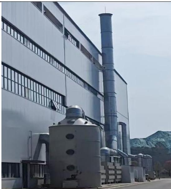
“碱喷塔+二级干燥过滤+二级活性炭”处理设施（TA002）+30米高排气筒（DA002）
