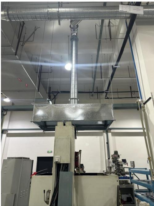
打磨废气、电加工废气集气罩
