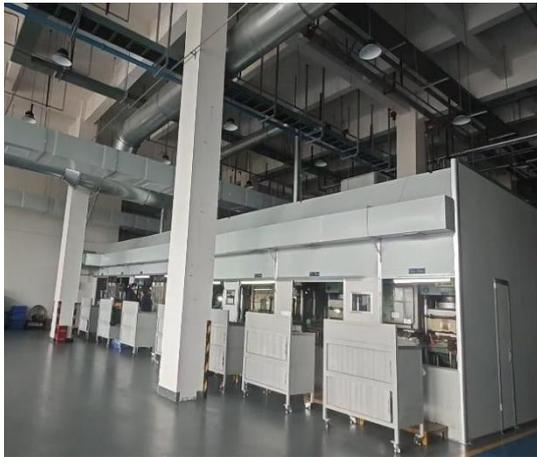
热压成型区废气收集
