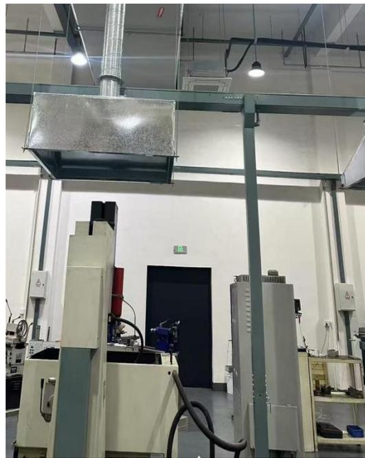
布袋除尘、打磨废气、电加工废气集气罩
