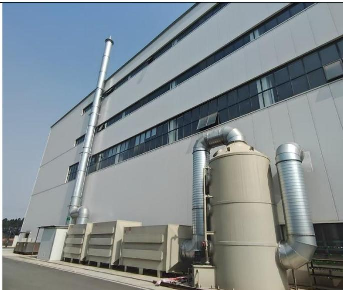
“氨气洗涤塔+一级干燥过滤+两级活性炭吸附”处理设施（TA003）+30m高排气筒（DA003）
